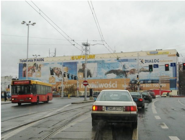
Rys. 5. Budynek Cyprum na placu Jana Pawła II.
